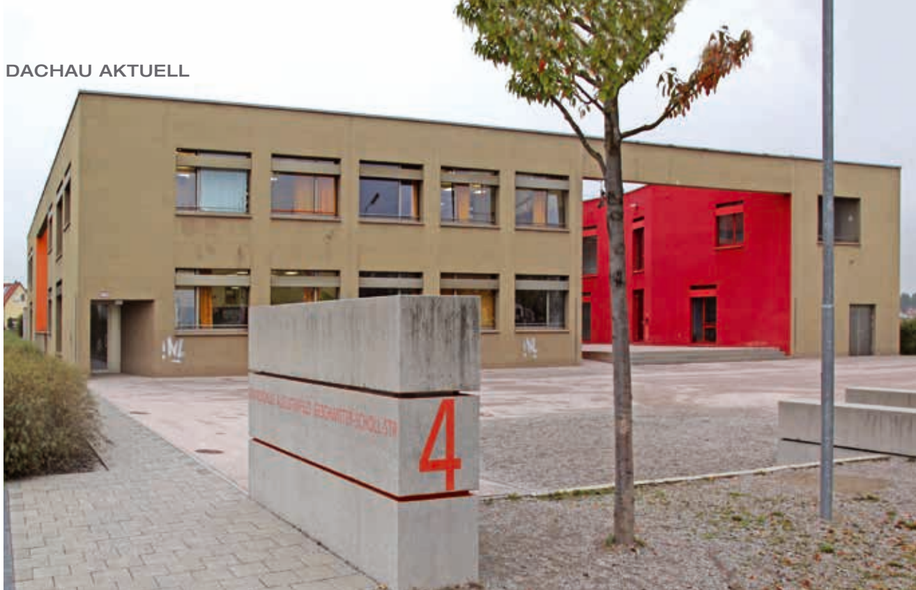
Dringender Erweiterungsbedarf: Die Grundschule Augustenfeld muss erweitert werden. Sie ist nicht die einzige Schule, in die erheblich investiert werden muss.
