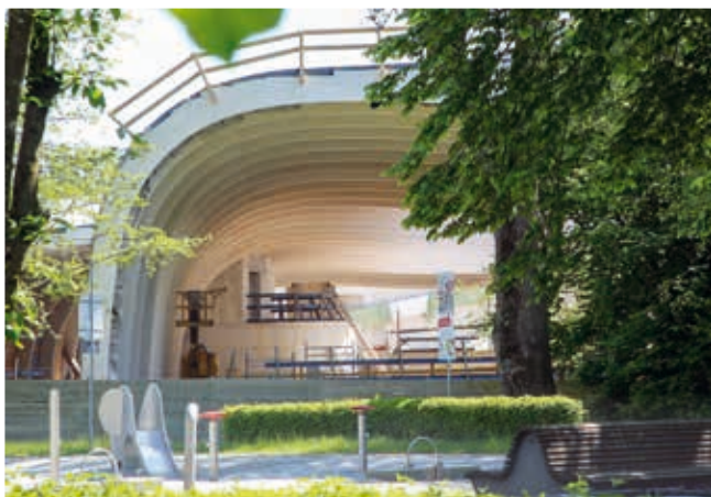
Dach abdichten, dann Innenausbau: Das neue Hallenbad in der Ludwig-Dill-Straße.
