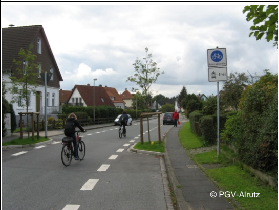
Beispiel Lemgo Fahrgasse (3,5-4 m breit) mit Breitstrichmarkierung (1 m Strich, 1 m Lücke); punktuelle Gehwegnasen zur Unterbrechung des linearen Parkens am Fahrbandrand
