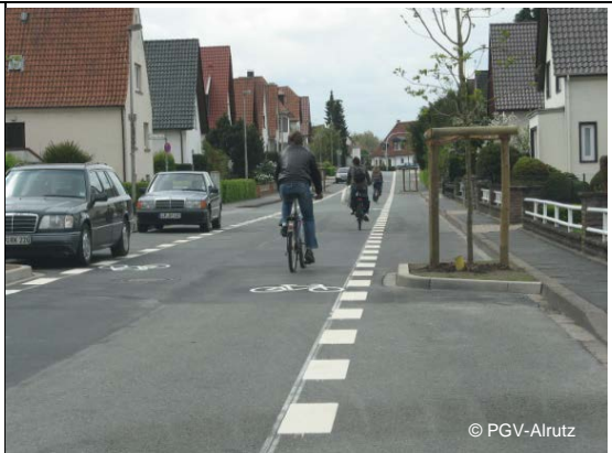
Beispiel Lemgo Fahrgasse (3,5-4 m breit) mit Breitstrichmarkierung (1 m Strich, 1 m Lücke); punktuelle Gehwegnasen zur Unterbrechung des linearen Parkens am Fahrbandrand
