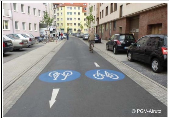
Beispiel Hannover Runde Piktogramme in Blau und Richtungspfeile im Straßenverlauf. Die Rinnen zwischen der asphaltierten Fahrbahn und den Parkständen sind farblich abgesetzt gepflastert und dienen als Sicherheitstrennstreifen.
