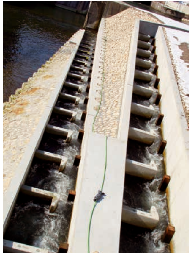
Mit der neuen Fischtreppe am Amper-Kraftwerk wird der Fluss wieder durchlässiger für Fische.
